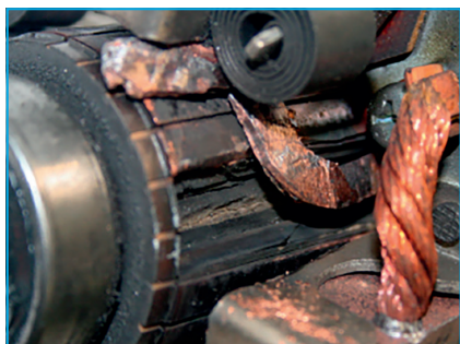
Повърхността на комутатора се е изтрила. Комутаторните сегменти са огънати.
