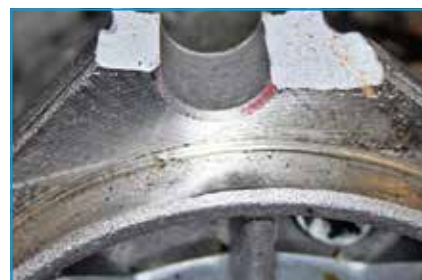
Orificiul șurubului de fixare al demarorului este fisurat din cauza manipulării incorecte, a instalării necorespunzătoare sau a strângerii excesive a șurubului motorului.
